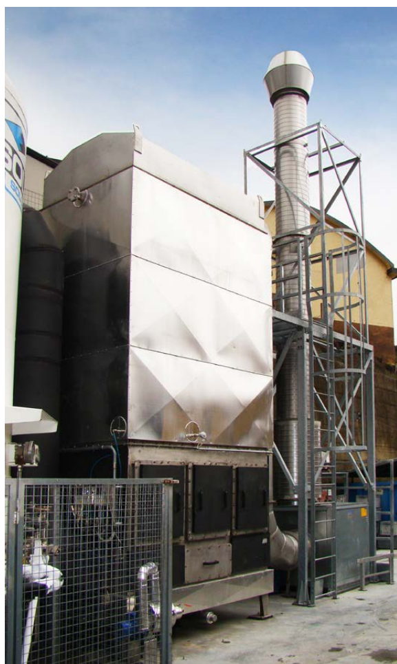
> Nuovo impianto a coalescenza per 3 forni installato presso la ditta CM in via Paoli
