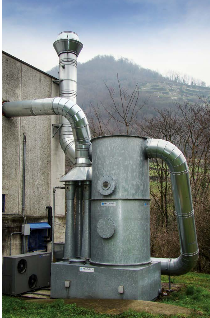
> Lo scrubber con venturi per presse e 1 forno a ciclo normale della ditta Punto Gomma in via Micizie Sotto. Qui verrà installato un impianto pilota a coalescenza con carboni attivi.
