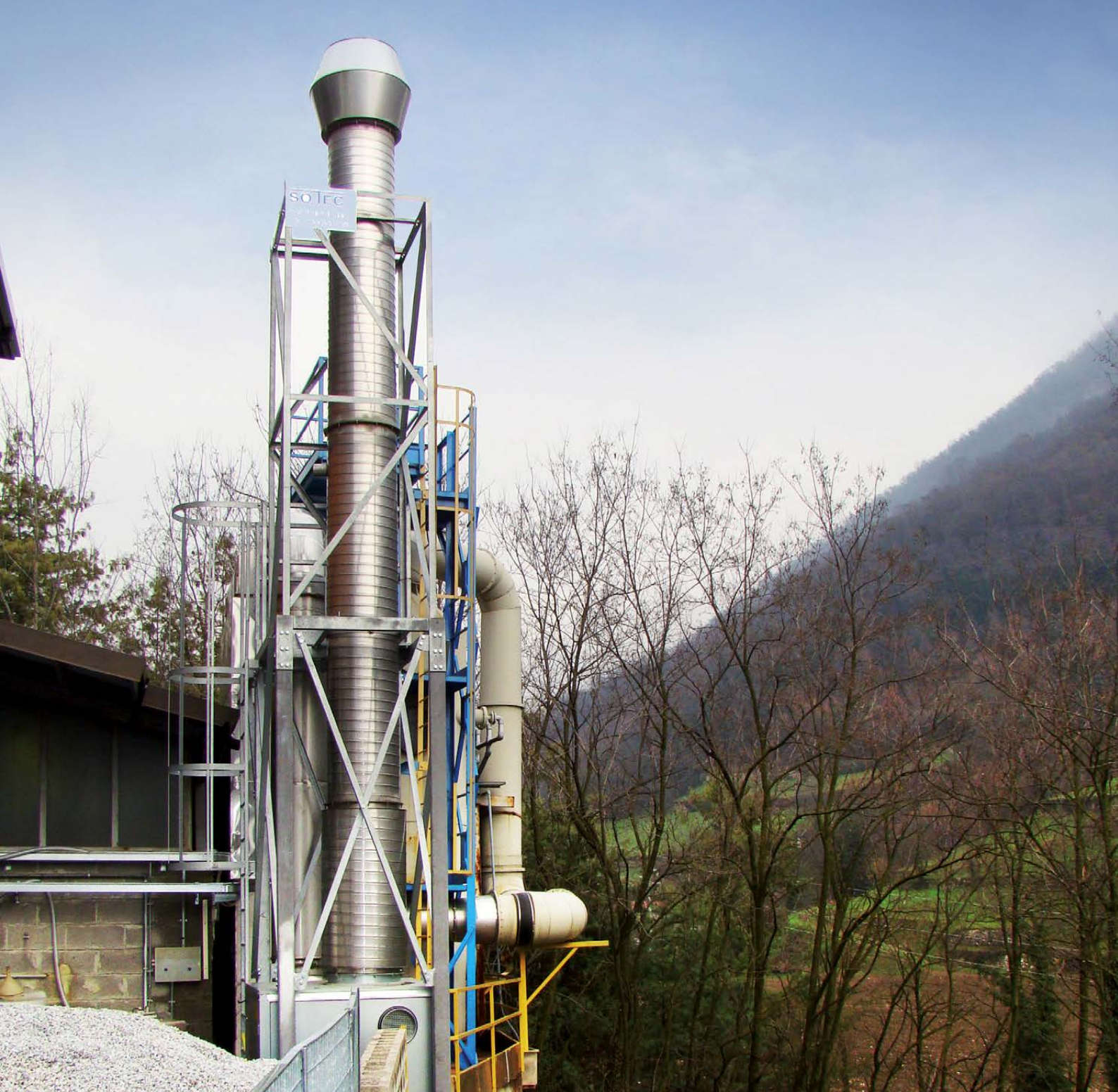
> Nuovo impianto a coalescenza per 6 forni a ciclo normale installato presso la ditta Tecnogomma in via Castello
