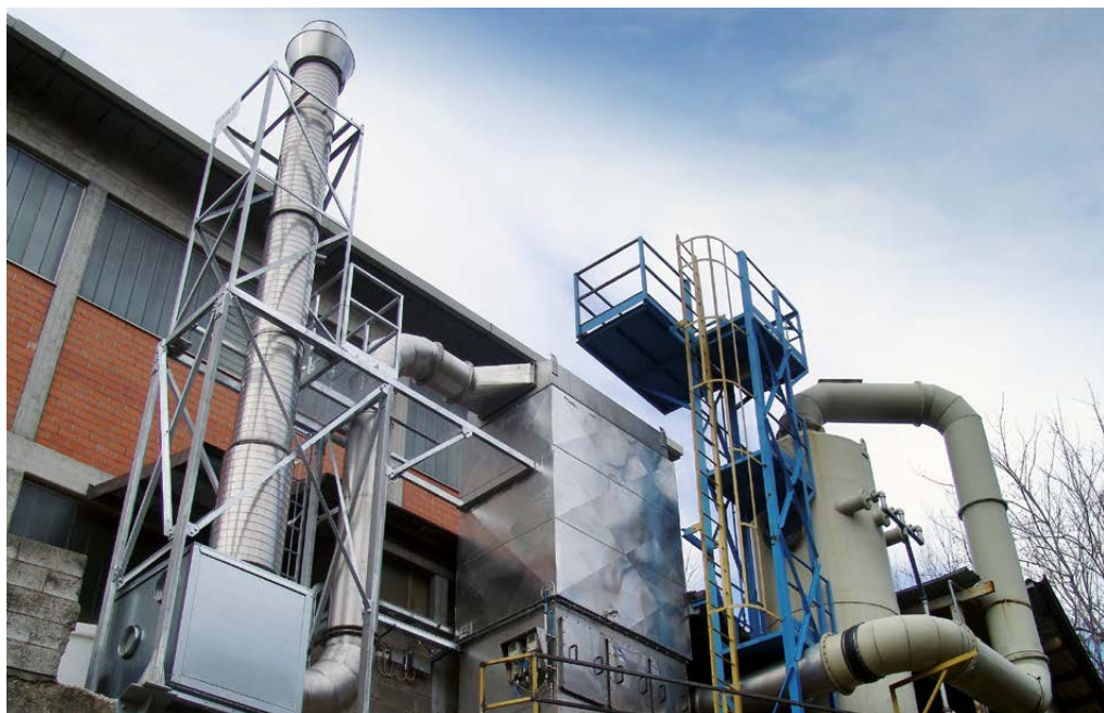
> Nuovo impianto a coalescenza per 6 forni a ciclo normale installato presso la ditta Tecnogomma in via Castello
