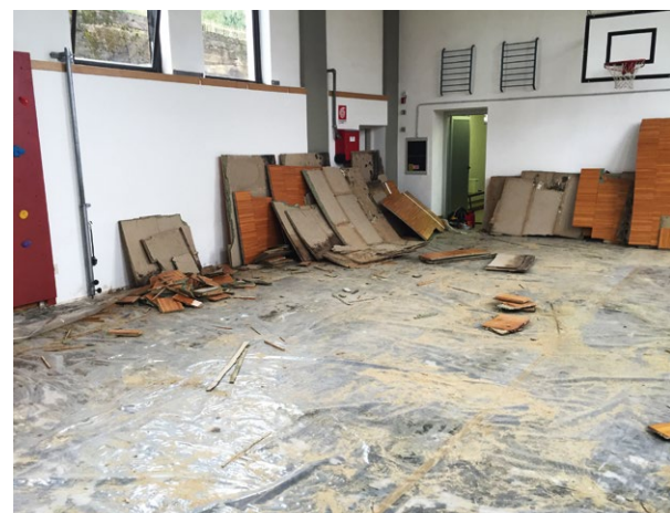
La pavimentazione della palestra della Scuola Elementare
